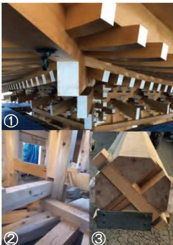
①垂木が見事！もちろんすべて手作業。②塔内部。様々な継手・仕口が使われています。③五重塔の要、心柱の根元。
